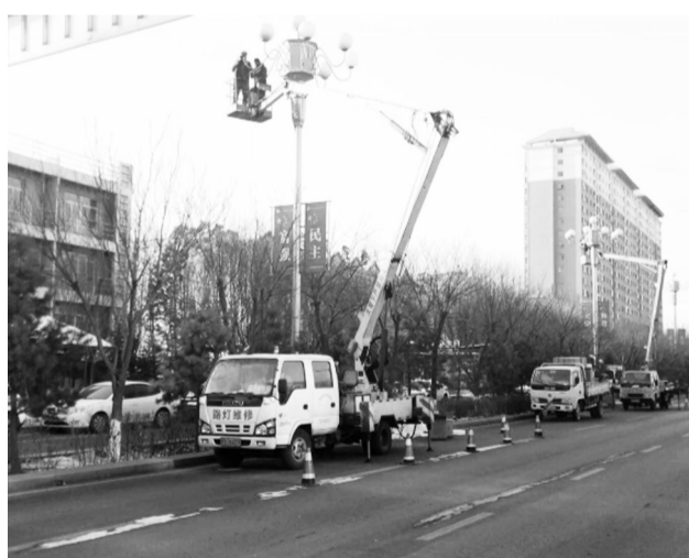
近期由市建设局城建科及市政公用设施管理处对辖区各条道路同时进行了路灯节能改造工程。更换原来高能耗高压钠灯为低能耗高亮度LED路灯。此项节能改造工程预计2019年春节前完工,集中对全市辖区体育大道等33条道路,及街区巷道的8798盏路灯灯具进行更换。
